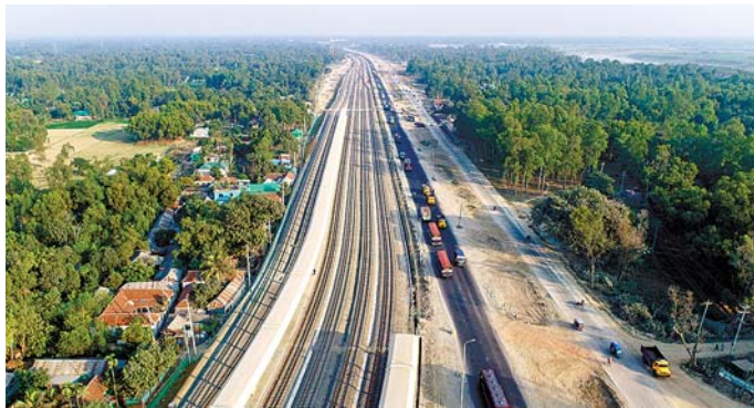
陸上軌道工の完成状況（駅部からダッカ側を望む）
