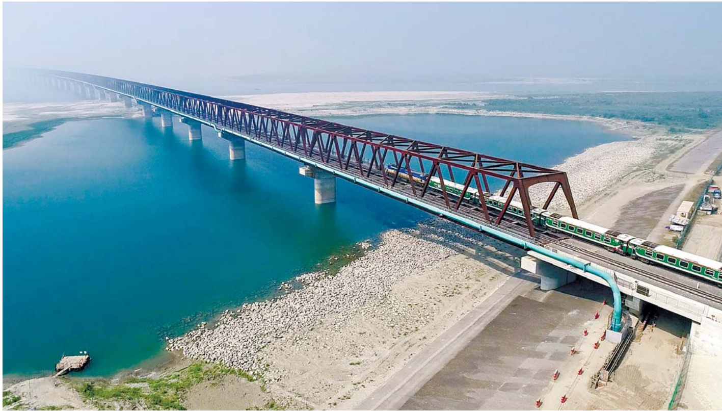
橋梁部の完成状況
