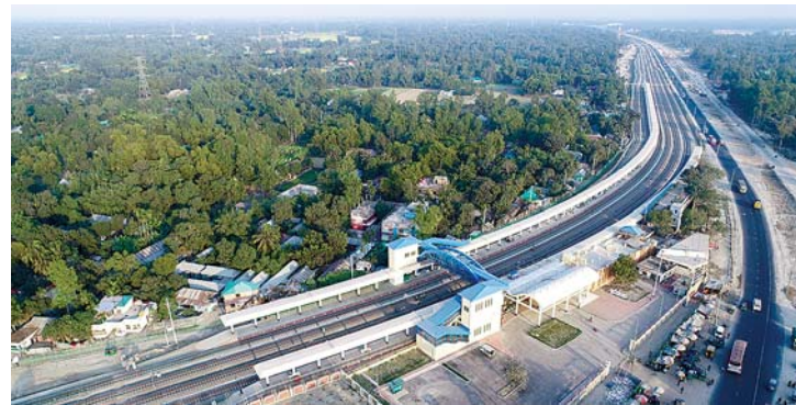
既存駅舎の改修工完成（左上がダッカ方向）
