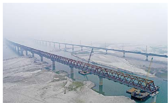
上部工（鋼トラス）の工区境到達時。ジャムナ川中央部、上流から下流側を望む
