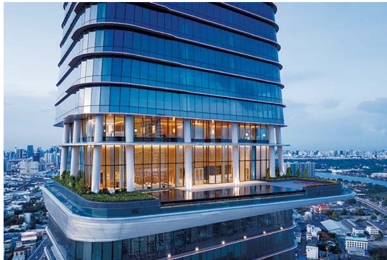
地上151階、39階から張り出して配置されたスカイラウンジ
