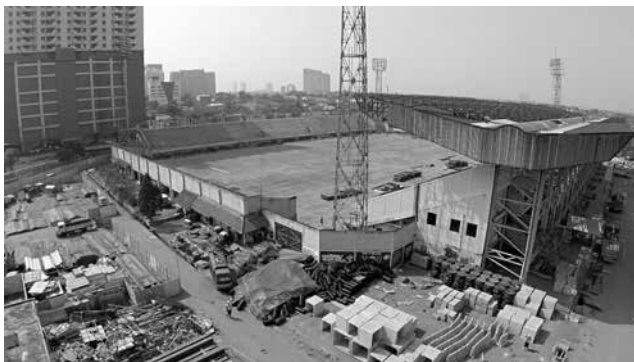
写真8 既存スタジアム解体中
