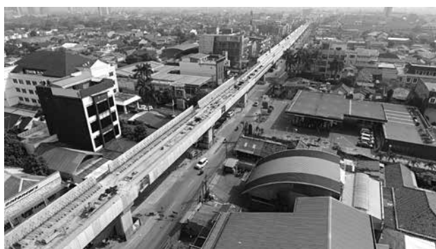
写真2 高架橋施工状況
