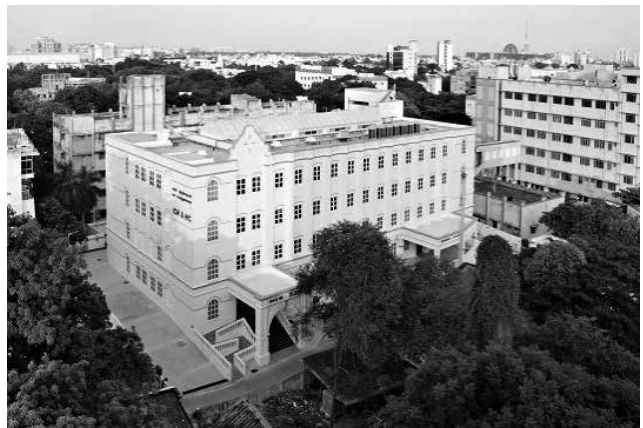
竣工全景写真
