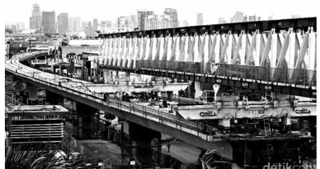
写真6 高架橋標準部；スパン・バイ・スパン工法
