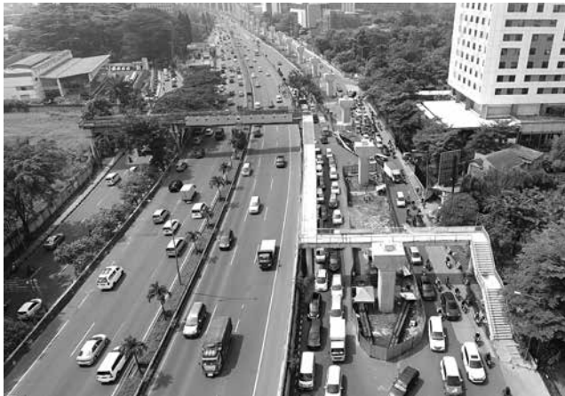
写真3 高架橋下部工
