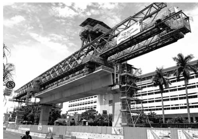
MRT CP103工区 ラウンディングガーダによる桁架設状況
