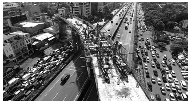
写真7 高架橋跨高速道路部；バランスドカンチレバー工法
