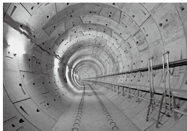
MRT CP104・CP105工区 シールドトンネル坑内
