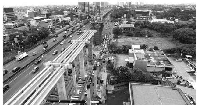
写真5 ファトマワティ駅部既設公共道路切回し状況
