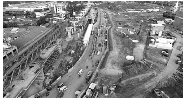
写真4 ルバックブルス駅部既設公共道路切回し状況
