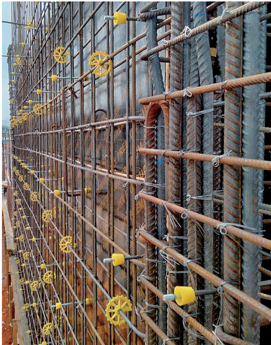
日本式の型枠工法を採用
