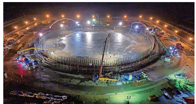
基礎版のコンクリート打設
