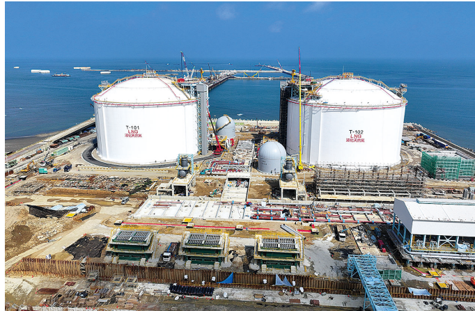
完成した2基のLNGタンク
