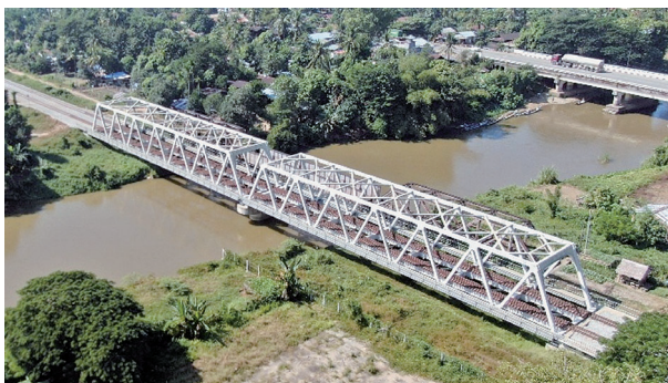
新しいトラス橋
