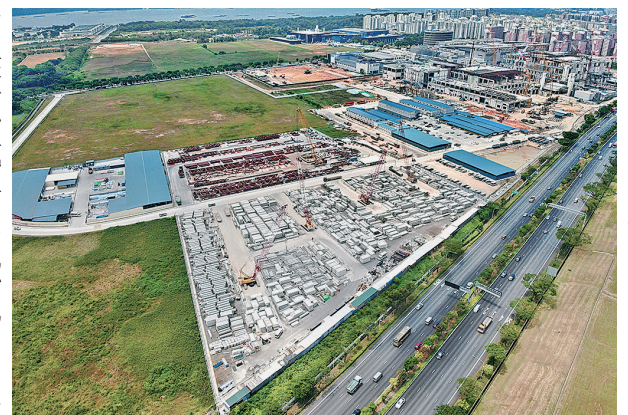
広大な仮設ヤード
