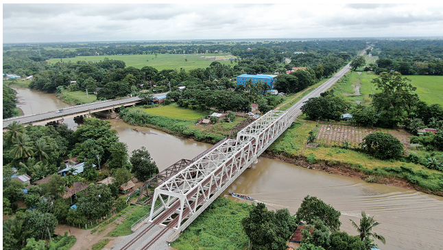
116B橋梁の全景
