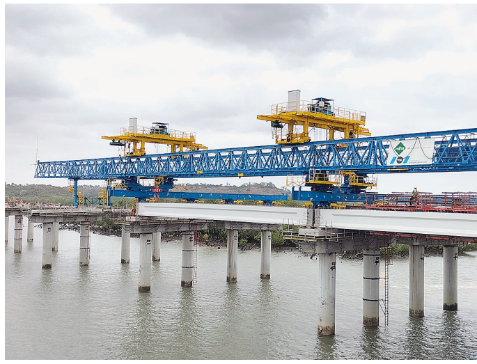
架設桁による桁の架設状況
