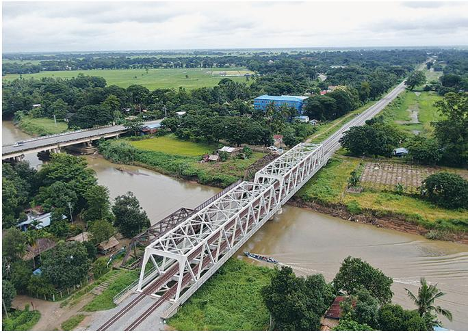
鉄建建設とりんかい日産建設による共同企業体はCP102工区を担当し、約80kmにわたる区間の改修を行った。旅客列車の最高運行速度は時速100kmに設定され、ヤンゴン・マンダレー間の所要時間を8時間以内に収めることを目標とした。現在、ヤンゴン・ネピドー間を約5・5時間で結ぶ営業運転が可能となった。
