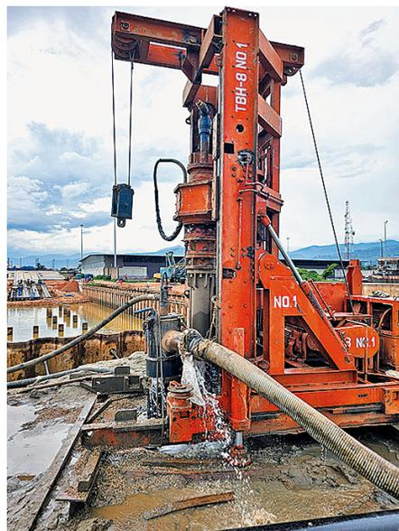
深さ(+761・0)まで二重管ストレーナーで薬液を注入し、陸側から掘削地盤に流入する地下水を遮断する方法と、16m鋼矢板壁根入れより1・5m深い高さ(+759・5)にディープウェルを設置し掘削地盤の地下水位を下げる工法のコストを試算。その結果、二重管ストレーナーによる薬液注入工法は薬液の輸送コストが極めて大きくなる一方、ディープウェルによる地下水低下工法は主な資材がケーシングパイプやスクリーンパイプで、薬液注入工法よりコストが低く抑えられることが分かった。
