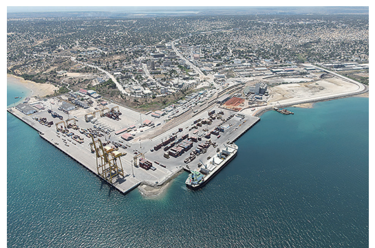
完成した工事の全景
