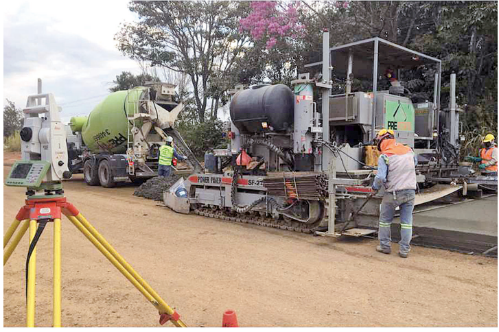
3D測量システムで舗装機械を制御し作業効率を高めた
