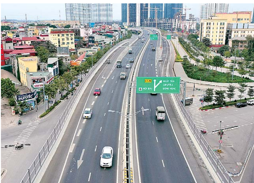
施工中④と完成後のハノイ環状道路3号線
