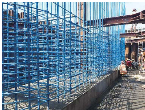
橋脚の鉄筋組み立て作業
