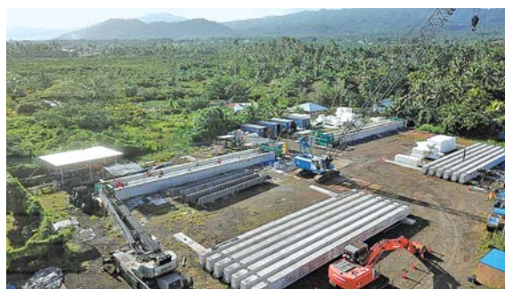
現地に整備した主桁の製作ヤード
