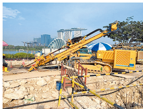
曲線削孔によるマリーナ貯水池直下の地盤改良
