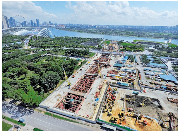
Thomson-East Coast 線ガーデンズバイザベイ駅施工状況
