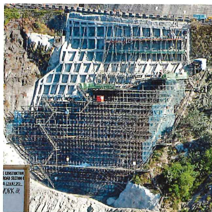
グラウンドアンカー工の足場と吹き付けのり杵工
