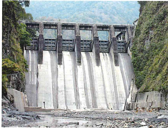
濁水溪に建設された武界ダム
