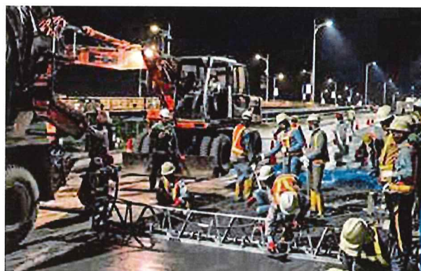
現地初のSFRS舗装作業
